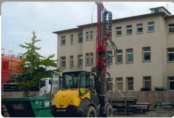
Bohrung Geothermie Klinikum
