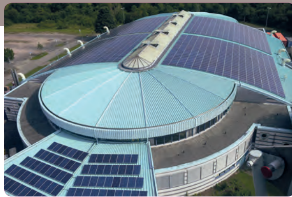
Bild links: Bürgersolaranlage Lindenschule
