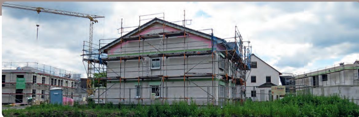
Passivhausbau Im Venussee
