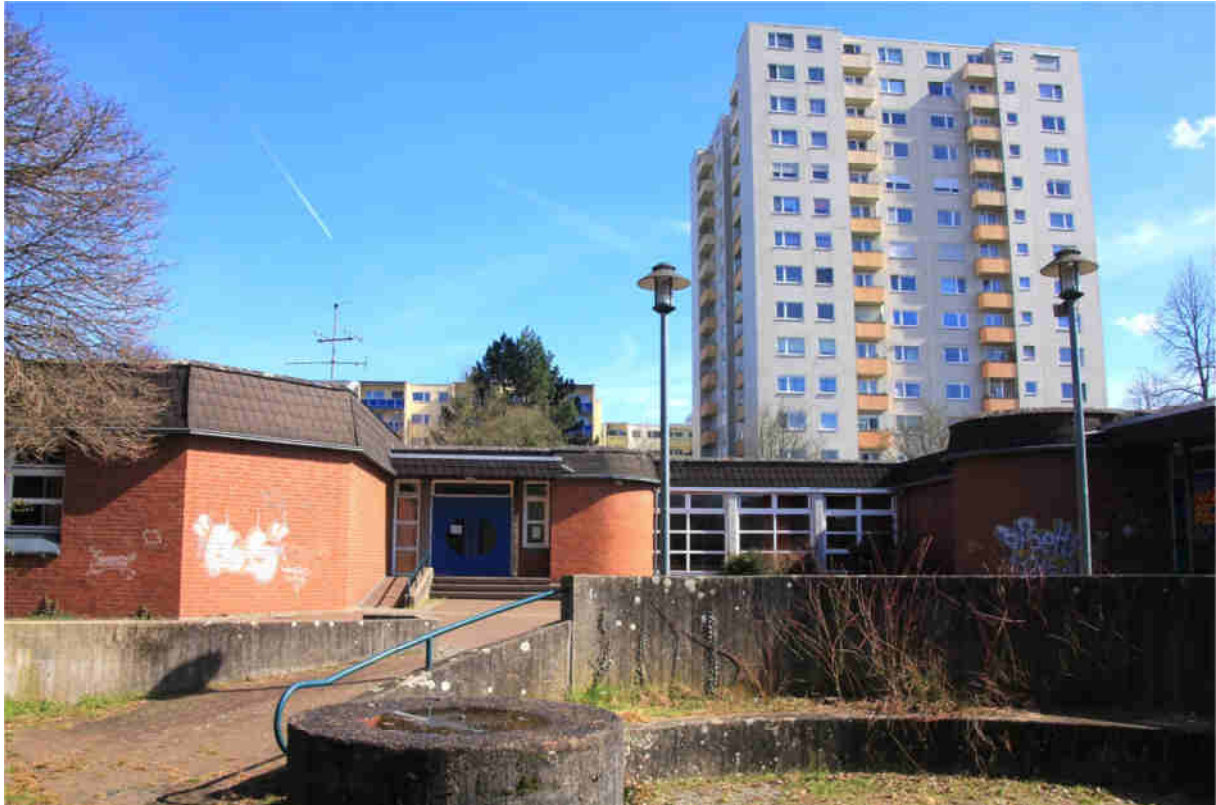
Abb. 1: Gemeindezentrum in der Helmholtzstraße.
