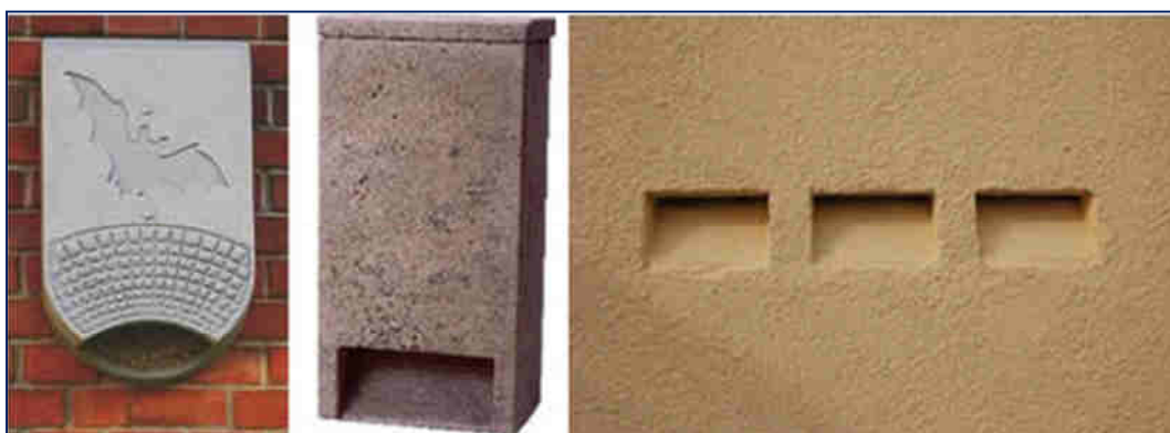
Abb. 8: Beispiele von Fledermauskästen zur Anbringung oder zum Einbau an Gebäuden.
