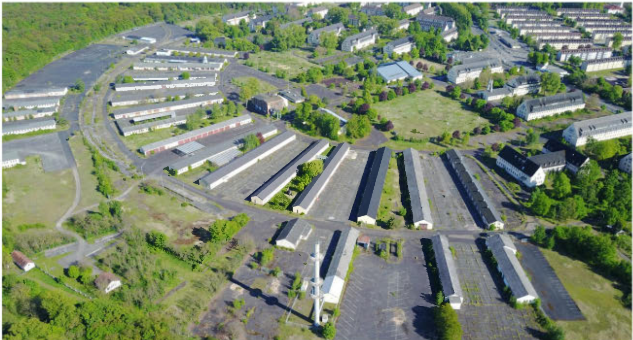
Abbildung 5: Luftbild Pioneer-Kaserne Hanau – der Fächer, Blick von Nordwest.
