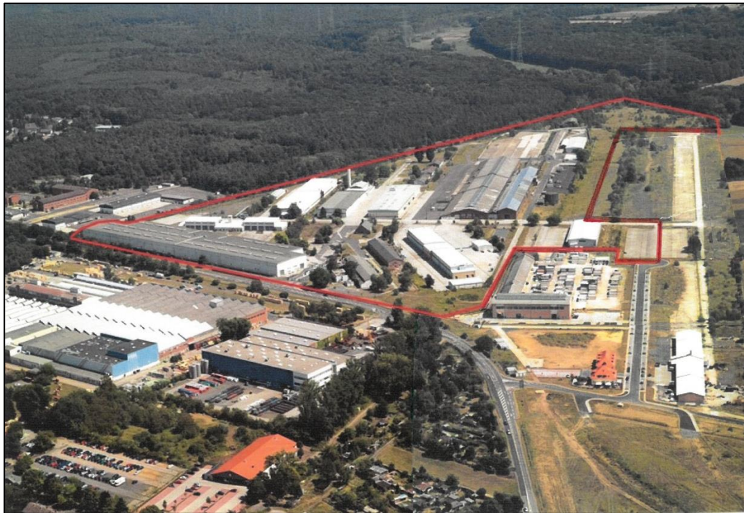
Abb. 11: Schrägluftbild Quelle: Bundesanstalt für Immobilienangelegenheiten
