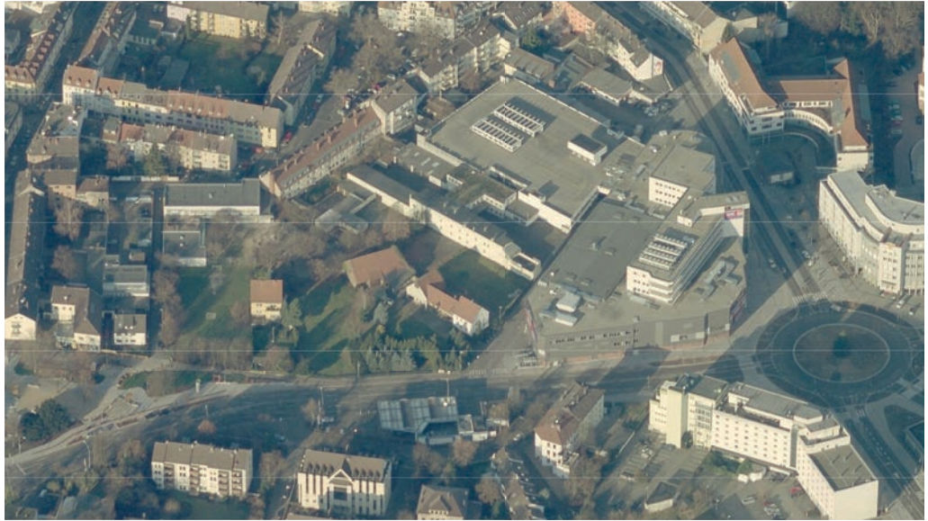
Plangebiet + Umfeld von Süden, vorne die Friedrich-Ebert-Anlage, rechts das City-Center mit der hohen Bebauung um den Kurt-Blaum-Platz und südlich der Friedrich-Ebert-Anlage. Mit den Festsetzungen zur Dichte wird dieser städtebaulichen Situation Rechnung getragen.
