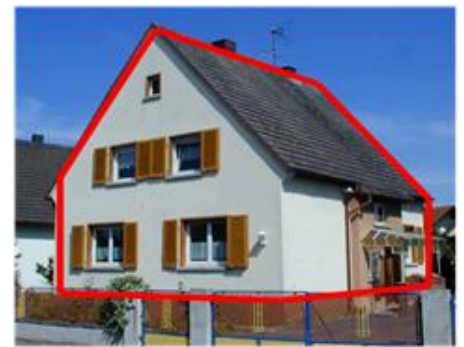
Abb. 68: Beispielhaus für umfassende Sanierung die beheizte Hülle ist rot markiert
